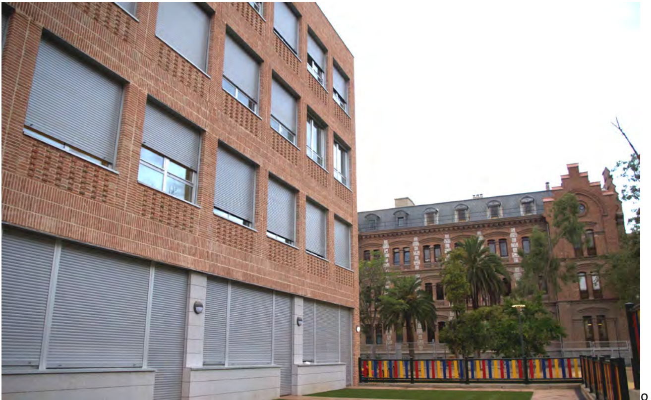
Colegio El Porvenir: Nuevo aulario con el edificio histórico al fondo.
